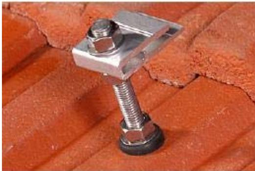
6: Установите нижний зажим на анкер (расстояние от кровли до зажима должно быть 20-30 мм)
